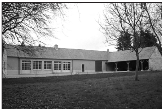
Les communs Saint-Joseph terminés
